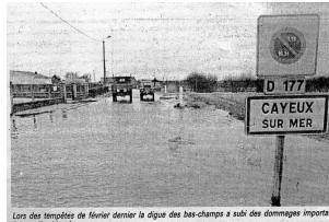
Lors des tempêtes de février dernier la digue des bas-champs a subi des dommages importants.
