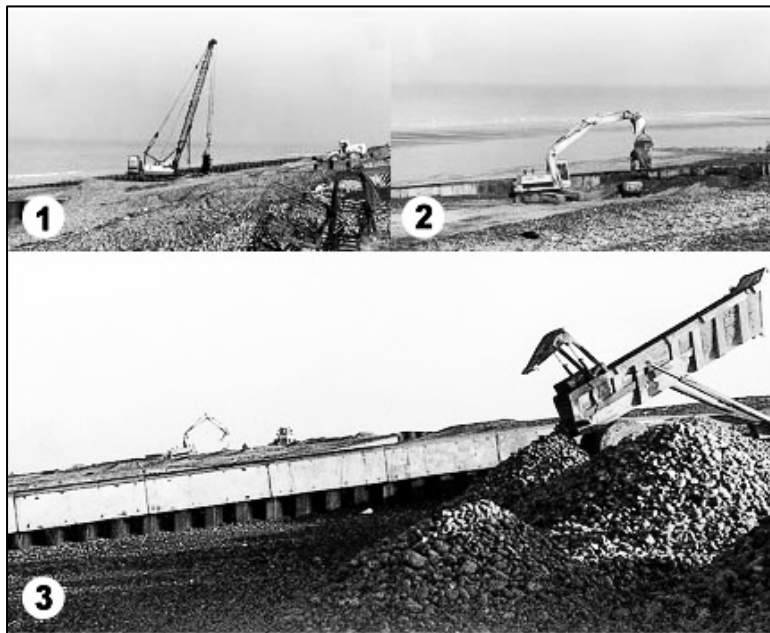
Fig.7. Construction des épis
