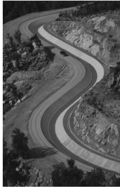
Figura 21 – CCG, vista aérea.
