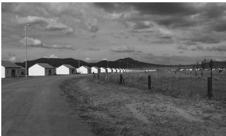
Figura 15 – Aspecto recente do antigo colonato da Cela
