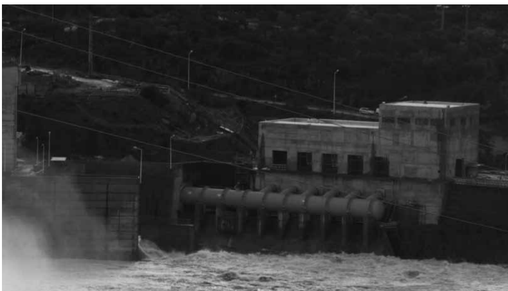
Figura 4 – Estação Elevatória do Pedrógão - Margem Esquerda. Vista geral a partir da margem direita.
