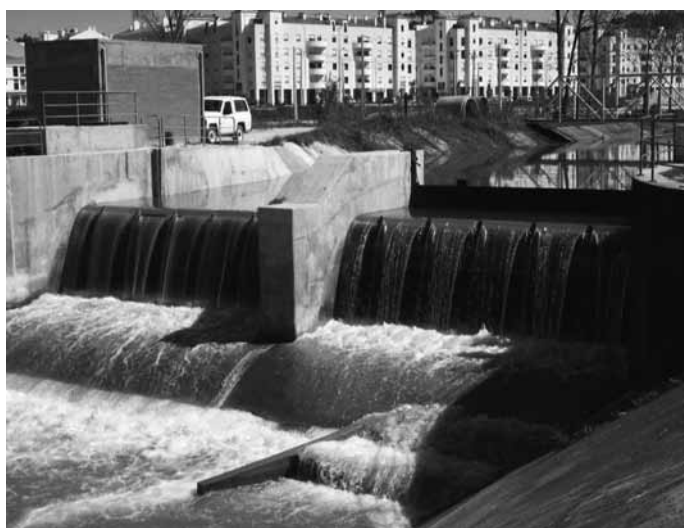
Figura 5 – Açude do Arrabalde reabilitado em plena carga: efeito dos arejadores montados na soleira do descarregador para evitar sub-pressões na face jusante das comportas.
