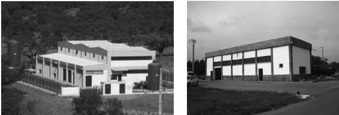
Figura 2 – Edifícios das estações de bombagem do Benaciate (esq.) e Minutos (dir.)
