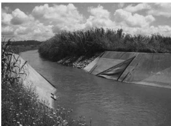
Figura 10 – Açude das Salgadas (após a reabilitação): no Inverno a tela fica aderida à secção menor do rio
