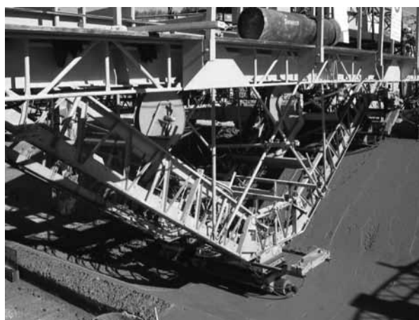
Figura 15 - Pavimentadora utilizada no 1º e 2º troços do CCG da Cova da Beira
