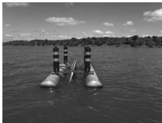
Figura 3 - Apoio na instalação dos cilindros de sinalização nas jangadas
