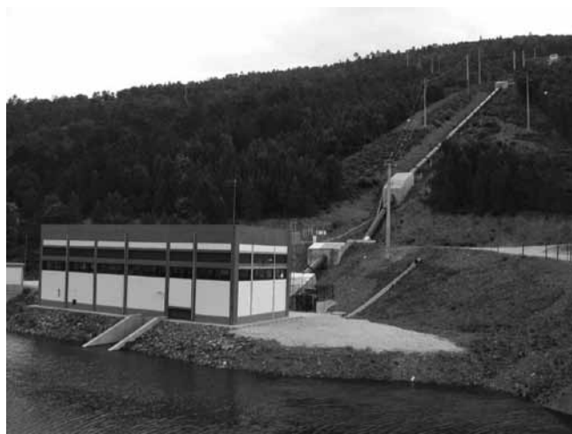
Figura 7 - Conduto forçada e Central do Meimão
