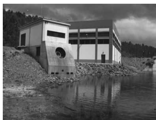
Figura 17 – Central do Meimão, edifício e válvula de jacto oco.
