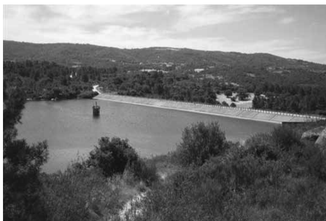
Figura 14 - Barragem de Arcossó vista de montante
