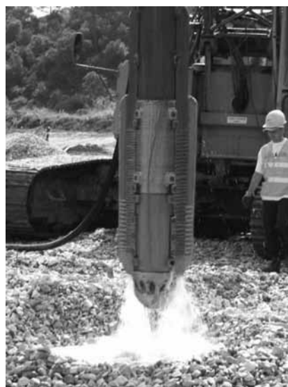
Figura 5 – Pormenor da ponta do vibrador.
