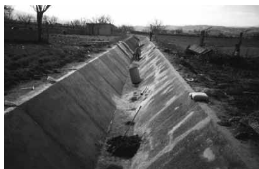
Figura 10 - Recuperação do Canal (Bloco I)
