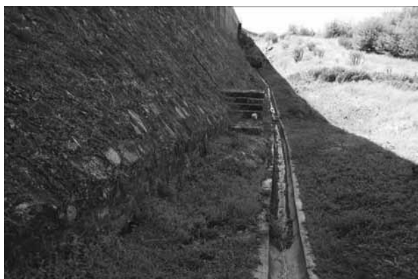
Figura 5 – Barragem da Póvoa. Infiltrações ao longo do corpo da barragem da Póvoa (Agosto 2009).
