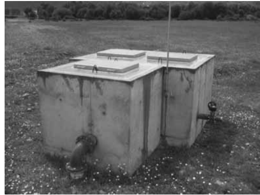
Figura 24 – Rede secundária de rega, hidrante.
