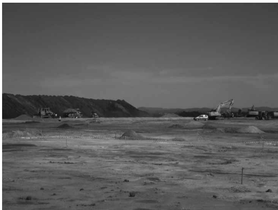
Figura 1 – Preparação e regularização da fundação
