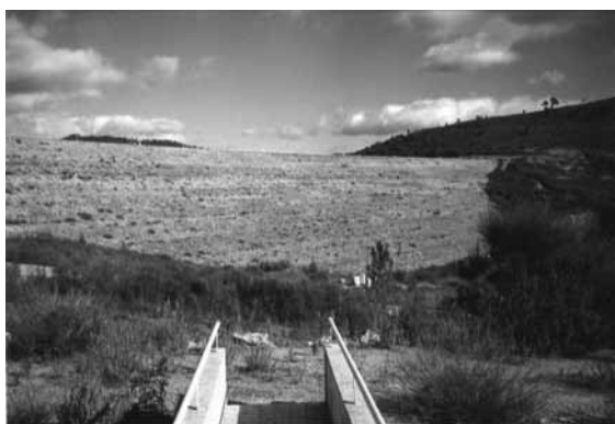
Figura 6 - Barragem da Meimoa, paramento de montante.
