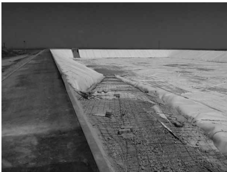
Figura 8 – Instalação da geomembrana e rampa de acesso ao reservatório
