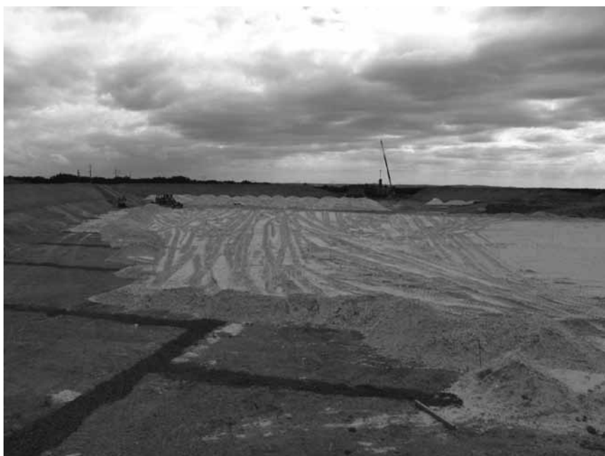
Figura 4 – Colocação da camada de base (é possível ver o sistema de drenagem interna)
