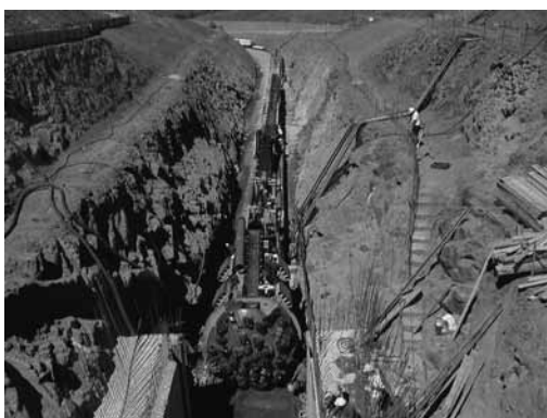
Figura 9 – Zona de acesso à entrada do túnel com a máquina já instalada
