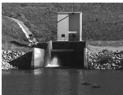
Figura 5 - Barragem do Sabugal, descarga de fundo.
