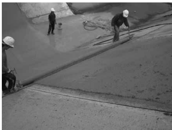
Figura 4 – Betonagem alternada de espadas com recurso a vários processos de vibração
