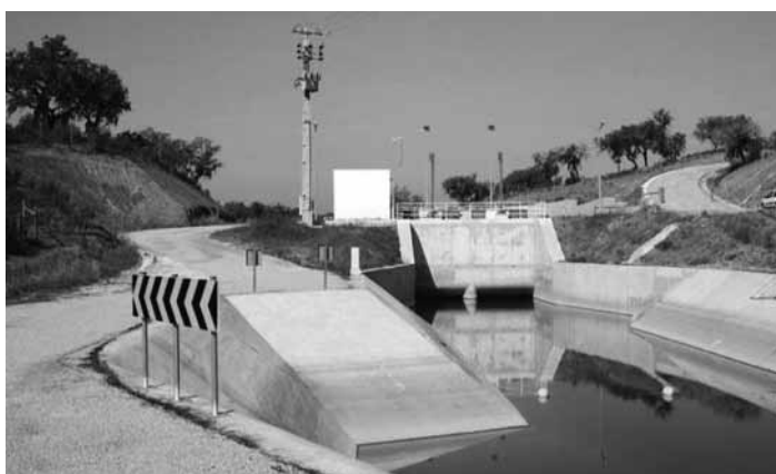
Figura 6 – Rampa de salvamento e acesso ao canal.
