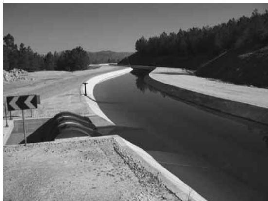
Figura 22 – Canal condutor geral
