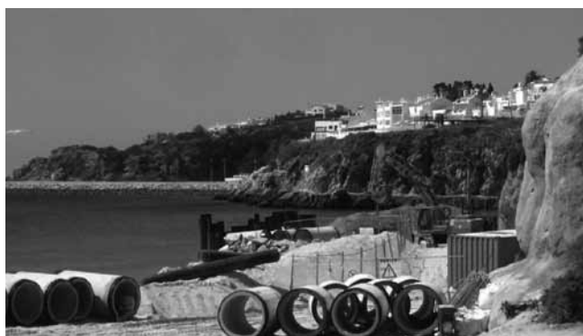
Figura 10 – Construção do Emissário Submarino de Albufeira
