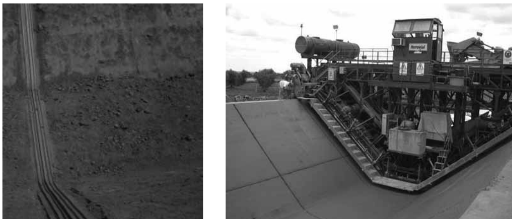
Figura 3 – Juntas nos canais. Aspecto do funcionamento do equipamento de betonagem, vibração e execução das juntas.
