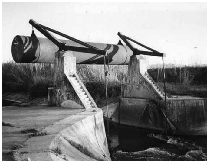
Figura 8 – Vista do açude das Salgadas anterior à reabilitação; aspecto do escoamento normal do rio no Inverno.
