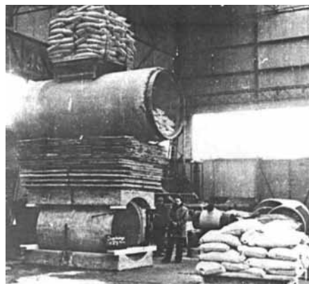
Figura 2 – Ensaio de compressão diametral ... em 1895
