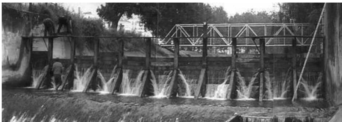
Figura 3 – Trabalhos de montagem do açude do Arrabalde inicial, realizados no início de cada campanha de rega
