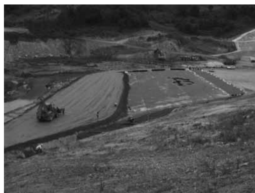
Figura 10 – Protecção do tapete impermeável.
