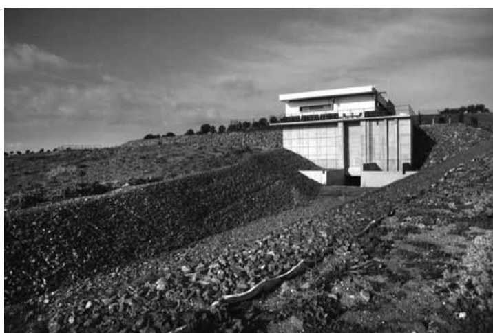
Figura 11 – AH do Pisão. Canal de restituição à albufeira do Pisão.
