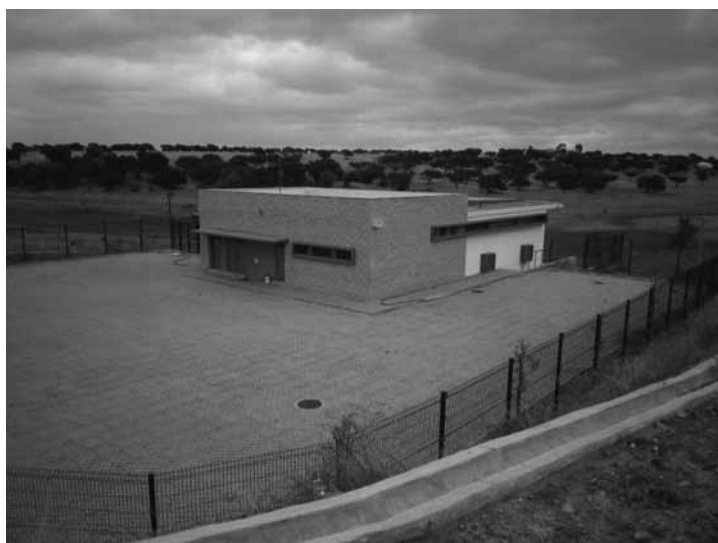
Figura 6 – AH de Odivelas. Edifício da central.
