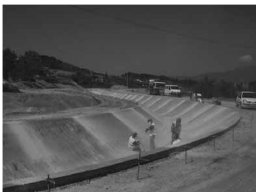
Figura 18 - Abertura de juntas de retracção
