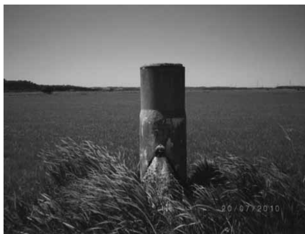
Figura 4 - Tomada de água alteada.
