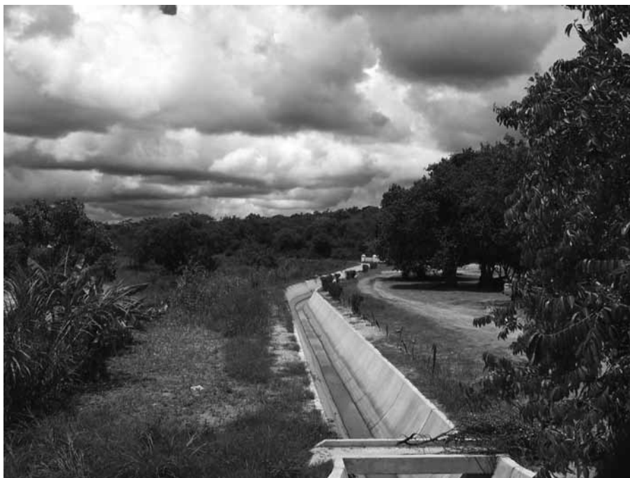
Figura 27 – Início do Canal C1 do Aproveitamento
