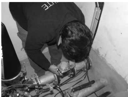
Figura 5 – Selagem e registo dos caudalímetros
