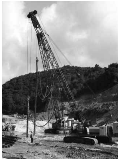
Figura 4 – Grua e vibrador.
