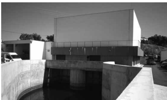
Figura 4 – AH de Alvito. Vista geral da central na zona de restituição ao canal.
