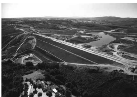
Figura 4 - Barragem do Sabugal, vista aérea durante a construção.
