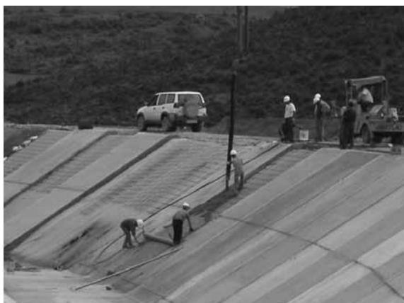
Figura 4 – Betonagem alternada de espadas com recurso a vários processos de vibração
