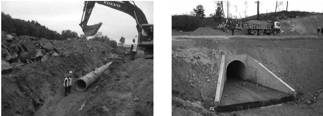
Figura 7 - Construção de passagens hidráulicas
