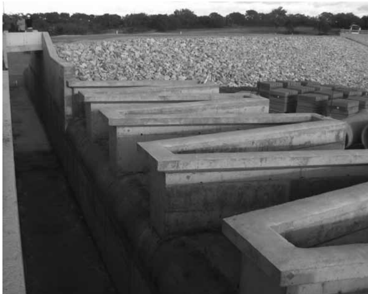
Figura 6 – Reservatório de Orada. Vista do descarregador de emergência (soleira em labirinto e canal colector) e do paramento de montante do aterro.
