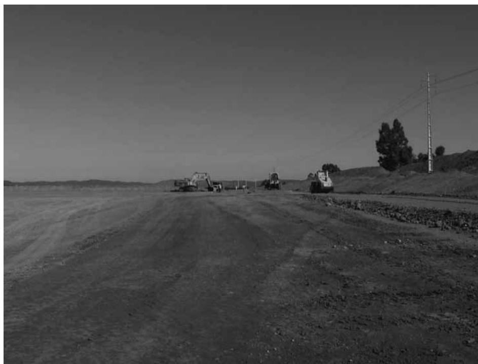
Figura 3 – Execução de aterro experimental
