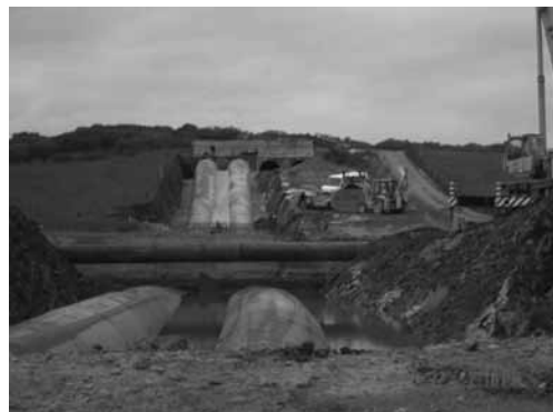
Figura 20 – Flutuabilidade em caso de inundação
