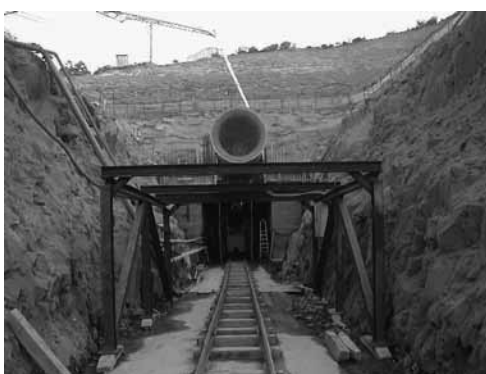
Figura 4 – Emboquilhamento de montante do túnel
