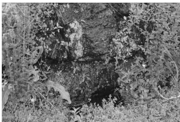
Figura 5 – Barragem da Póvoa. Infiltrações ao longo do corpo da barragem da Póvoa (Agosto 2009).
