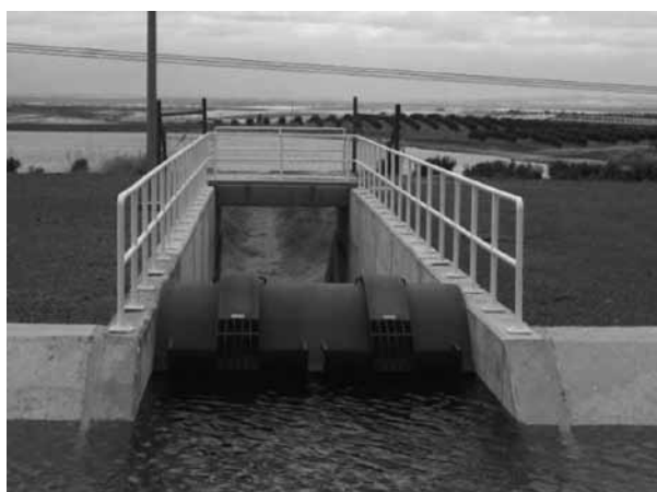
Figura 7 – Descarregador de segurança.
