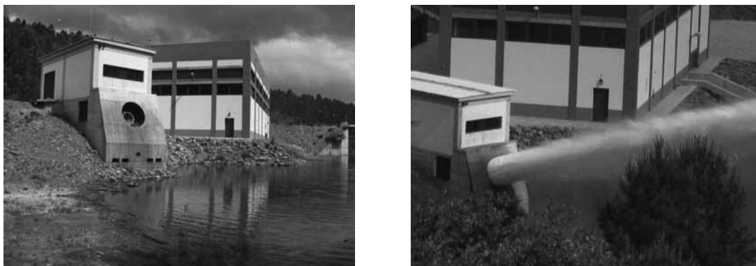
Figura 6 - Camara da válvula dispersora
