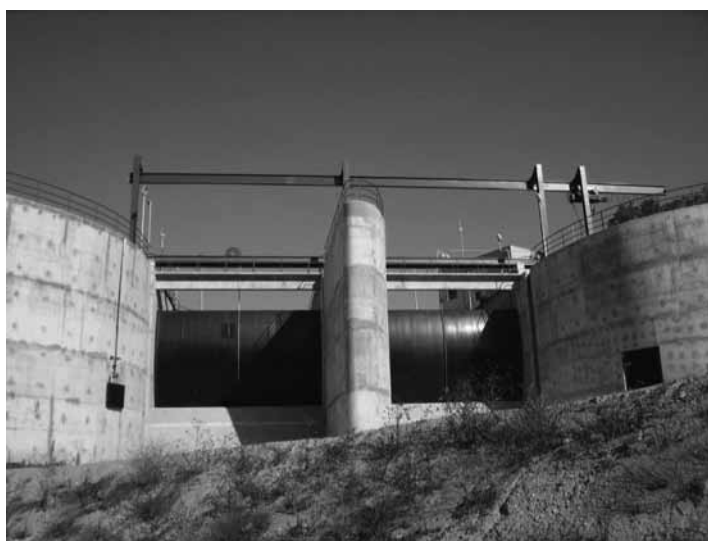
Figura 11 – Descarregador de cheias montante.
