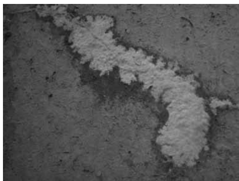
Figura 22 – Colmatação de fissura
