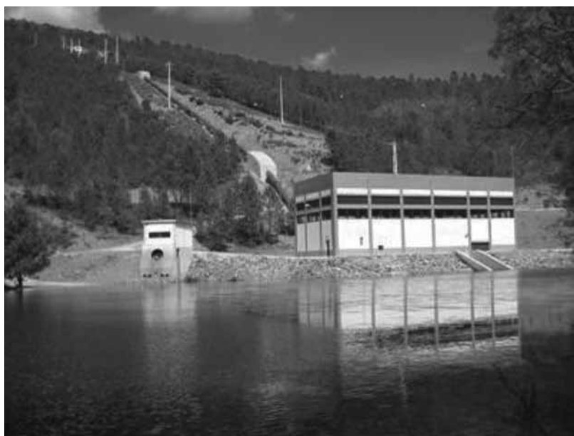
Figura 1 – Mini-hídrica do Meimão - Conduta, Central e Válvula de Jacto-Oco
