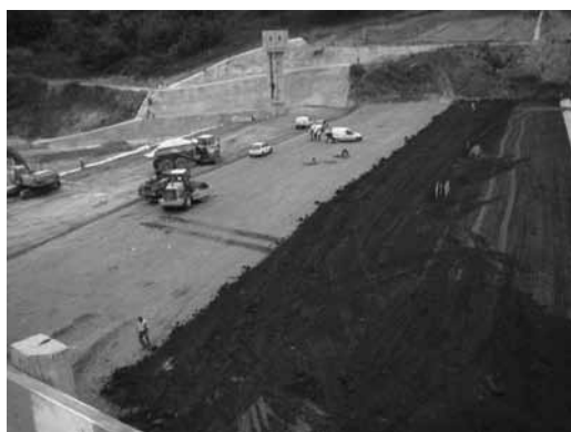
Figura 9 – Aterro, maciço de montante e núcleo.
