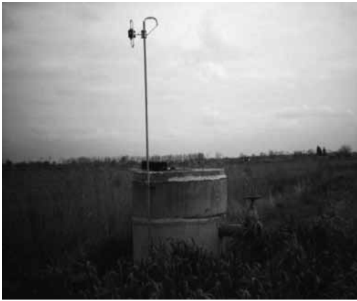
Figura 5 – Hidrante equipado com sistema de emissão via rádio e sinópticos
