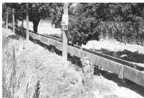
Figura 9 - Bloco I - regadeira
