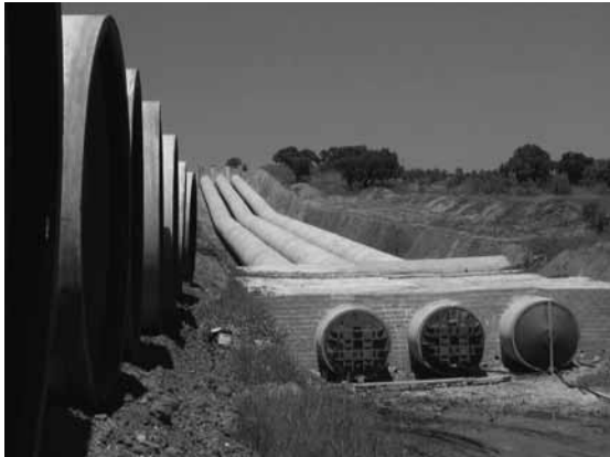
Figura 17 – Prova de estanquidade da conduta
