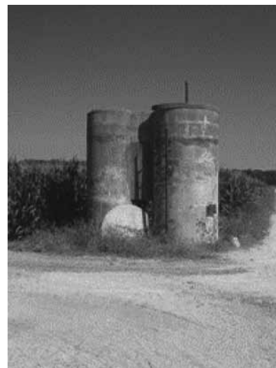
Figura 5 - Tomadas de água.
