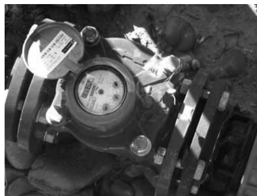
Figura 5 – Selagem e registo dos caudalímetros
