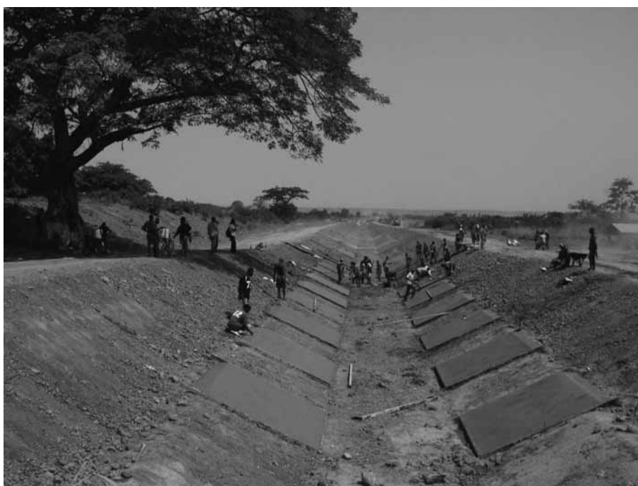
Figura 2 – Canal de Caxito em fase de revestimento
