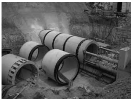
Figura 11 – Passagem sob o IP2 em São Manços
