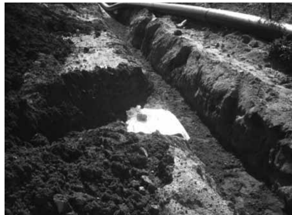
Figura 11 – Abertura da vala no sítio.
