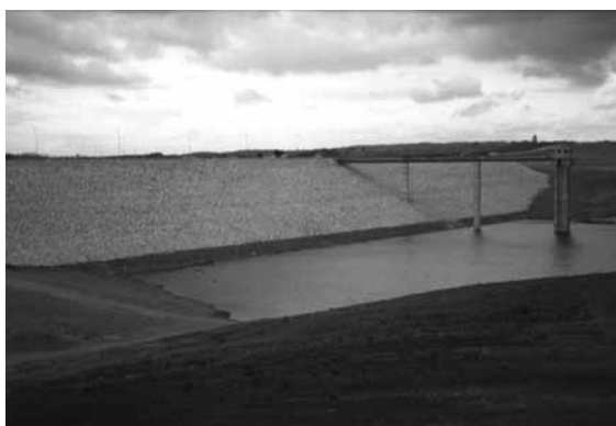
Figura 2 - Barragem do Sabugal, paramento de montante.
