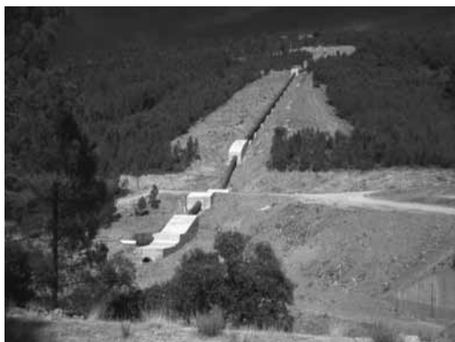
Figura 9 - Circuito Hidráulico Sabugal-Meimoa, conduta forçada.
