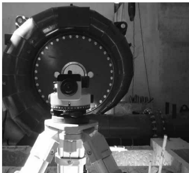
Figura 9 – Posicionamento da turbina
