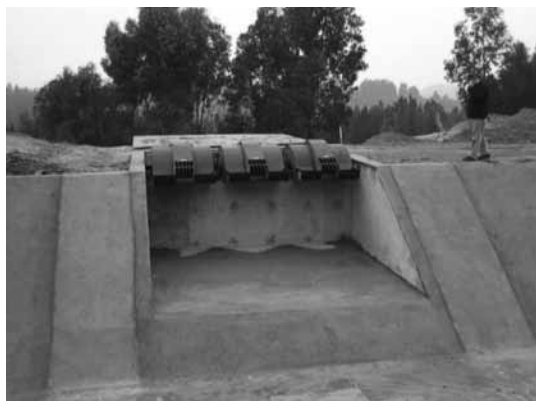
Figura 13 – secção especial, limpa grelhas
