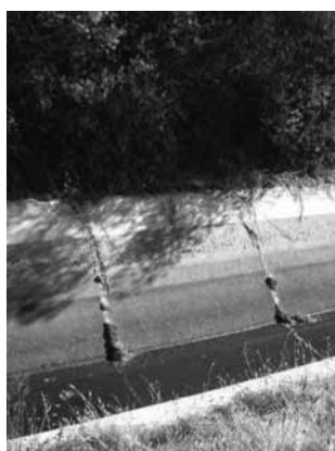
Figura 1 – Vegetação em contacto com o revestimento
