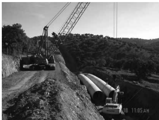
Figura 15 – Movimentação de tubos – colocação em vala
