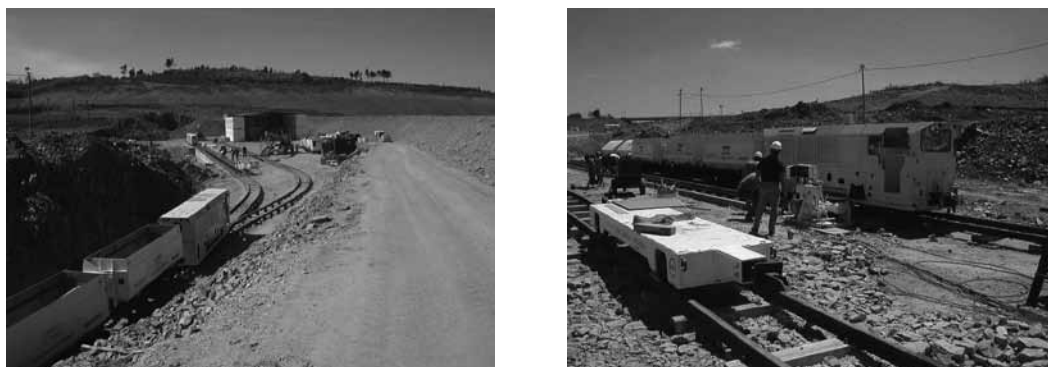
Figura 10 - Construção da enscadeira e da plataforma de apoio
