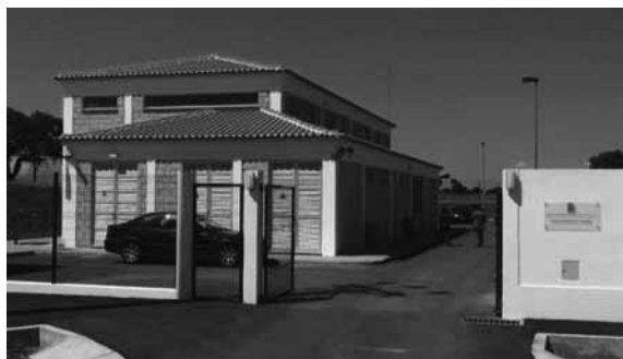
Figura 7 – Vista geral da estação elevatória.
