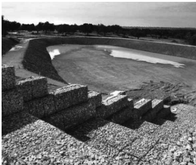
Figura 10 – Bacia de retenção.
