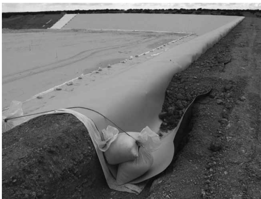
Figura 5 – Pormenor construtivo da fixação da geomembrana
