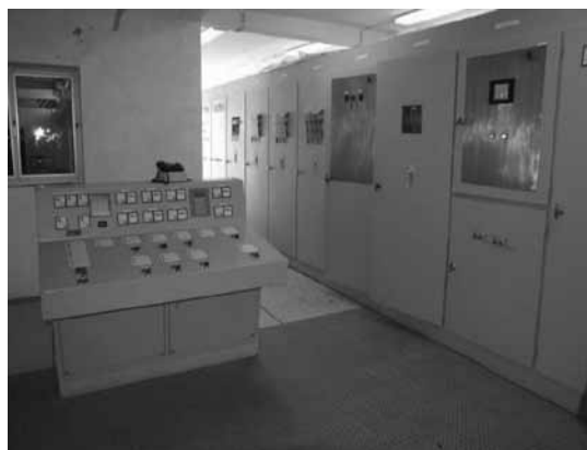
Figura 3 – Quadros de comando da estação de Bombagem do Benaciate (esq.)
