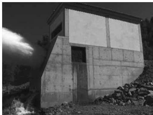
Figura 10 - Circuito Hidráulico Sabugal-Meimoa, válvula de jacto oco.
