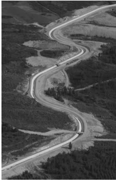
Figura 20 – CCG, vista aérea.
