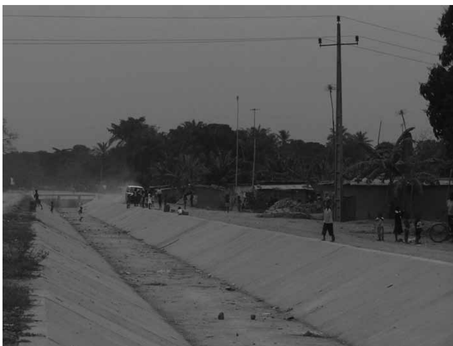
Figura 3 – Canal de Caxito revestido
