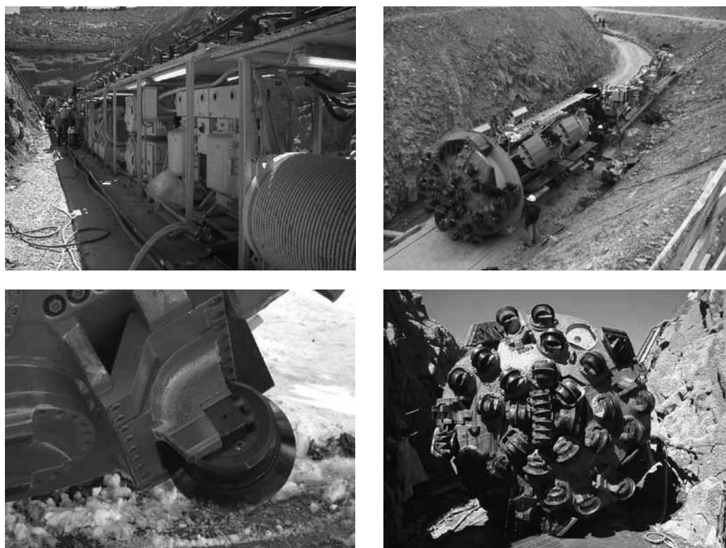
Figura 11 - Montagem da tuneladora na boca de montante
