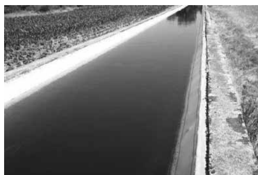
Figura 11 - Canal já revestido com PVC
