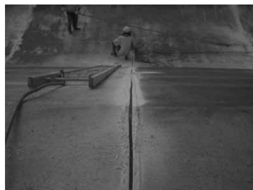
Figura 18 - Abertura de juntas de retracção
