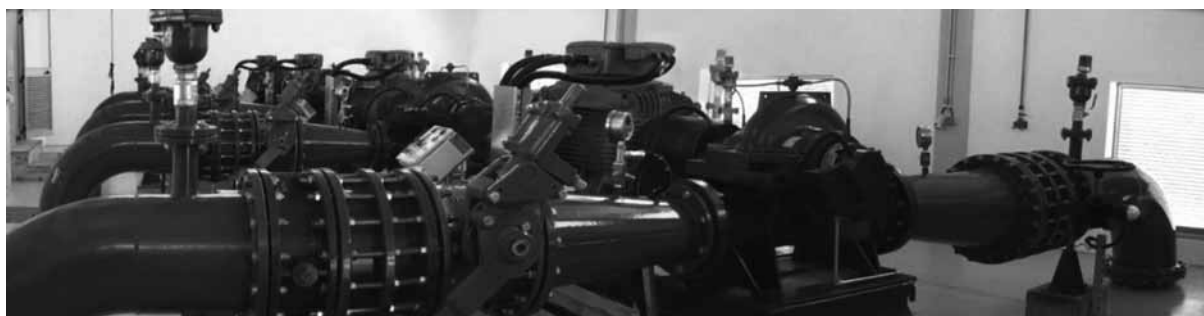
Figura 8 – Vista geral da nave dos grupos.
