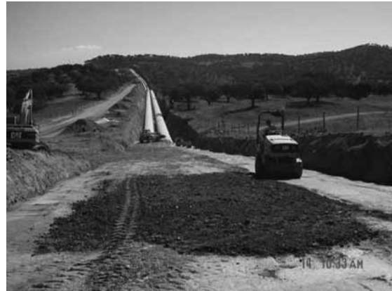
Figura 18 – Aterro final da conduta
