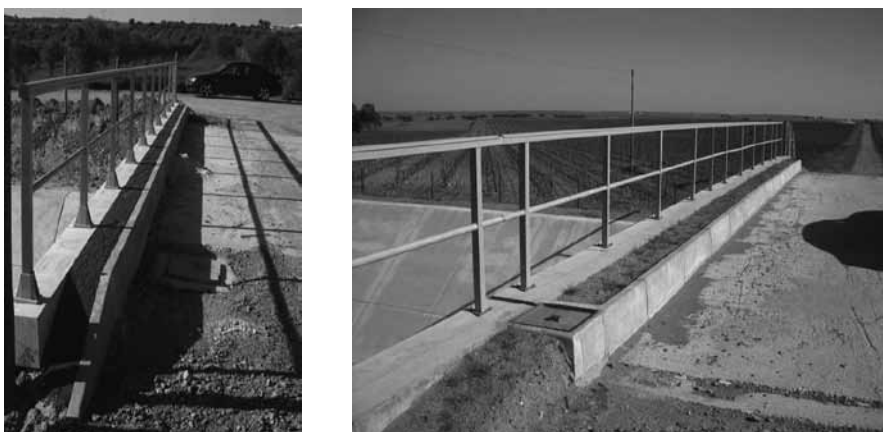
Figura 8 – Zonas de passagem para fauna nas passagens superiores.
