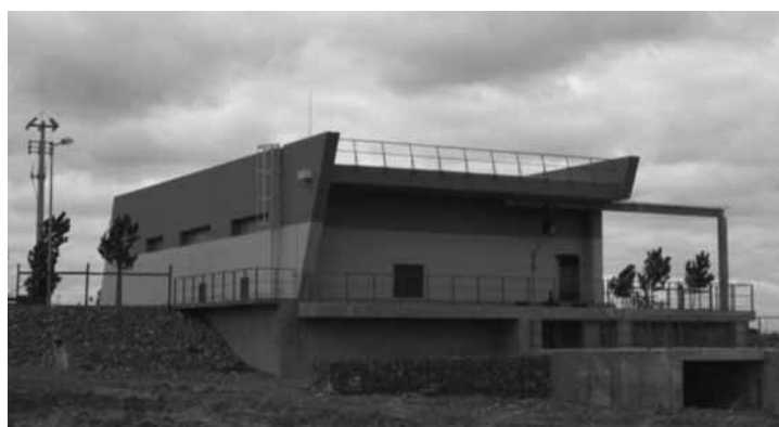
Figura 12 – AH do Roxo. Vista geral da central.
