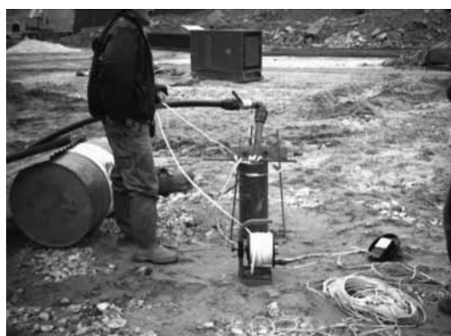
Figura 7 – Ensaio de permeabilidade.
