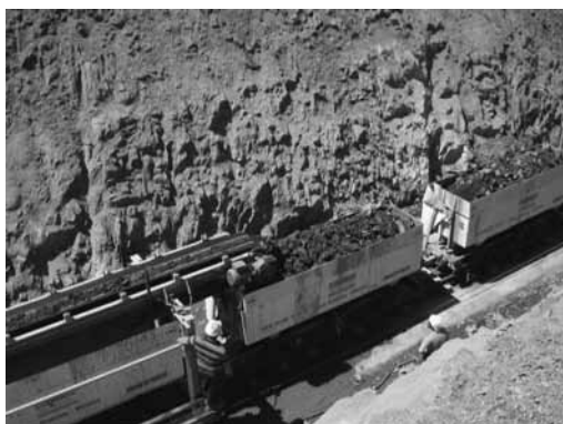
Figura 12 - Comboio de apoio à tuneladora
