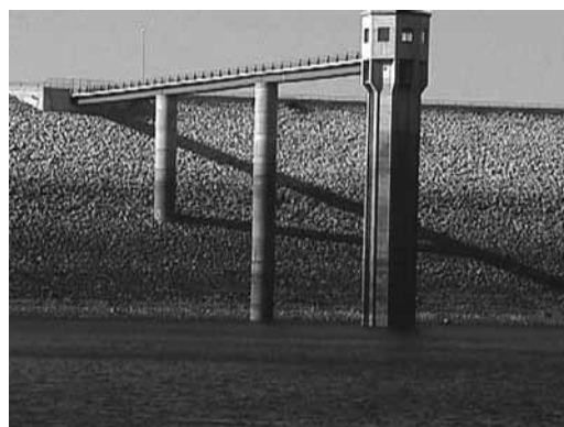
Figura 3 - Barragem do Sabugal, torre da tomada de água.
