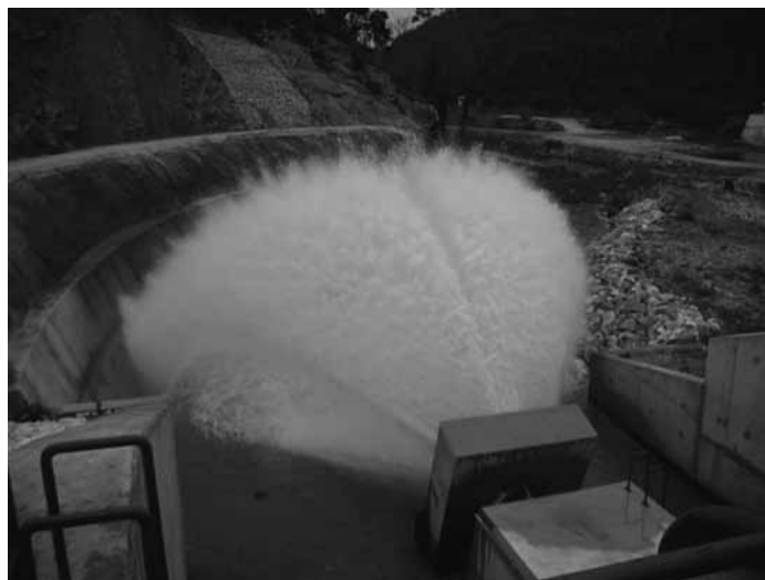
Figura 13 – Descarga de fundo, válvula de jacto oco.
