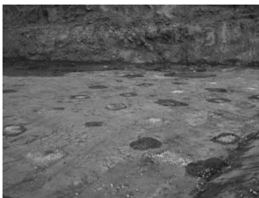
Figura 6 – Aspecto das colunas após saneamento.
