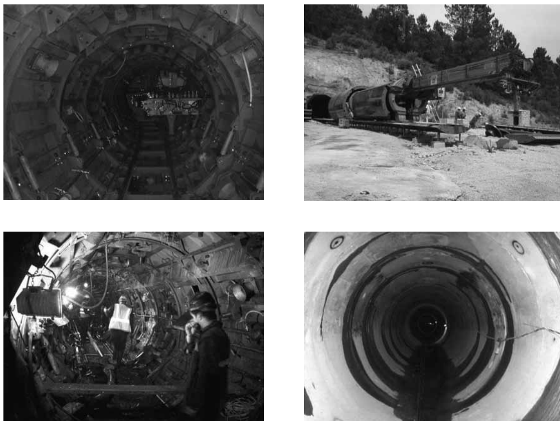
Figura 13 - Cofragem telescópica utilizada na betonagem
