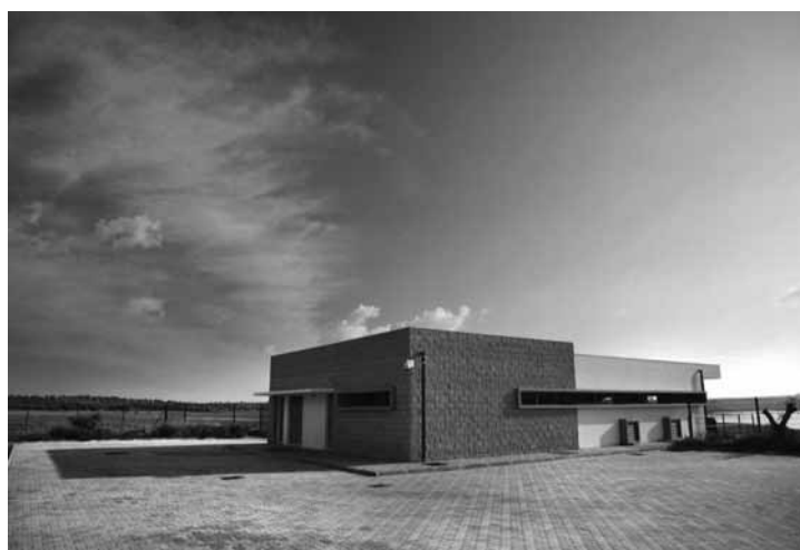
Figura 9 – AH do Pisão. Edifício da central.
