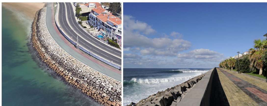
Figura 1. Exemplos de estruturas de proteção marginal (fonte: (esq.) GoogleEarth; (dir.) https://viagallica.com ).
