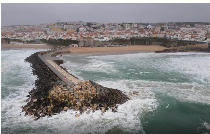
Figura 1. Quebra-mar do porto da Ericeira. Fonte: DGRM.
