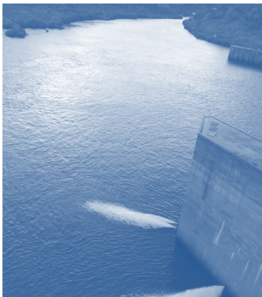
Barragem de Carrapateiro, vista para jusante (Eclusa Borland e jactos de chamada)
