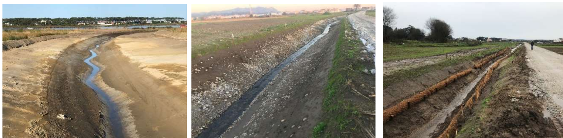
Fig. 3. Fotografias da área de intervenção do Sistema Intercetor e de Desvio da Área Urbana de Esposende (SIDESP)
