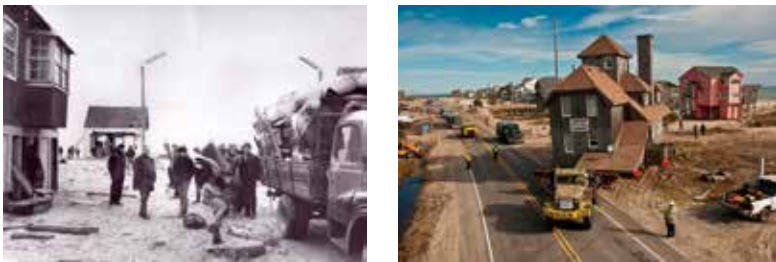
Figura 8.33 - À esquerda, galgamento em Esmoriz (autor desconhecido) e à direita evidências das vantagens das estruturas ligeiras ou amovíveis (fonte: David Alan Harvay, Magum).
