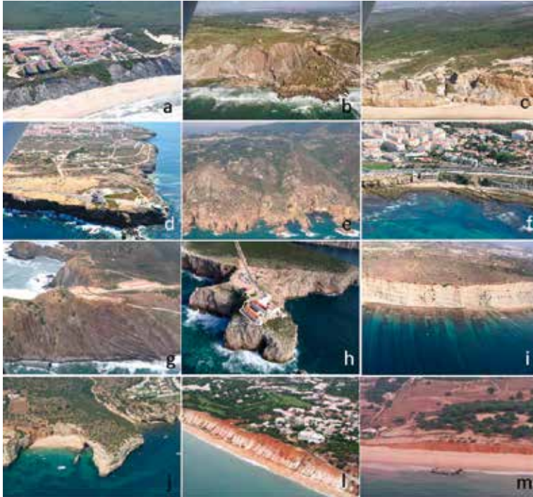
Figura 3 - Exemplos de arribas no litoral de Portugal Continental talhadas em diferentes litologias: a) Margas calcárias (Pedra do Ouro – Alcobaça); b) Arenitos argilosos (norte da Foz do Arelho – Caldas da Rainha); c) Arenitos argilosos (Praia d´El Rey – Óbidos); d) Calcários (Cabo Carvoeiro – Peniche); e) Arenitos e calcários margosos (Praia da Bafureira – Cascais); f) Granitos (Cabo Roca – Sintra); g) Xistos, Arrifana (Aljezur); h) Dolomitos (Cabo S. Vicente – Vila do Bispo); i) – Margas, Porto de Mós (Lagos); j) Calcarenitos (Praia do Pontal – Lagoa); l) Arenitos argilosos (Praia da Falésia – Albufeira); m) Arenitos argilosos (Forte Novo – Loulé).
