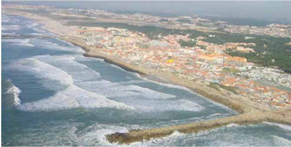
Figura 8.19 - Defesa frontal de Esmoriz sem praia em frente à obra.
