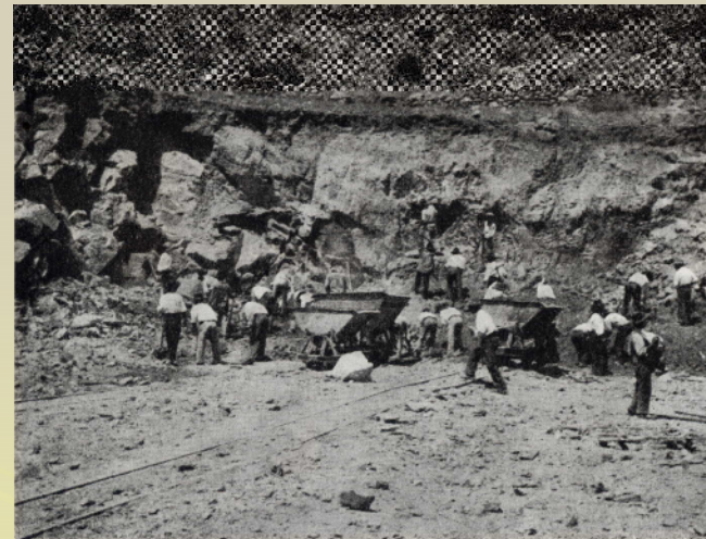
OBRA N.º 8 Rega da Campina da Idanha Abertura do descarregador de superfície
