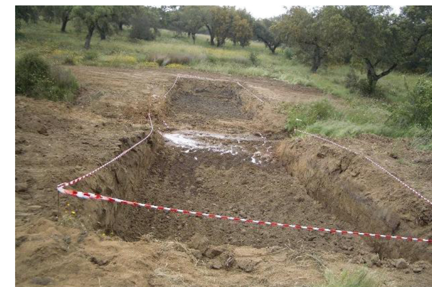
Construção de soleiras para retenção de água nas ribeiras no período de estiagem
