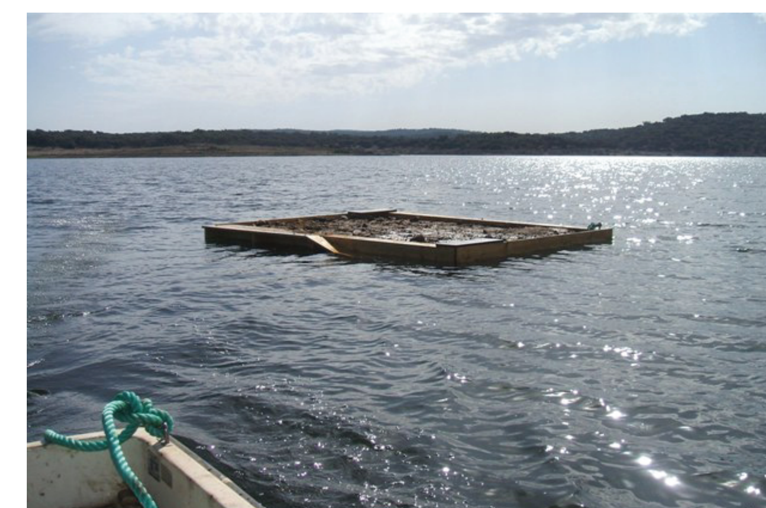
Construção de plataformas flutuantes para aves e peixes
