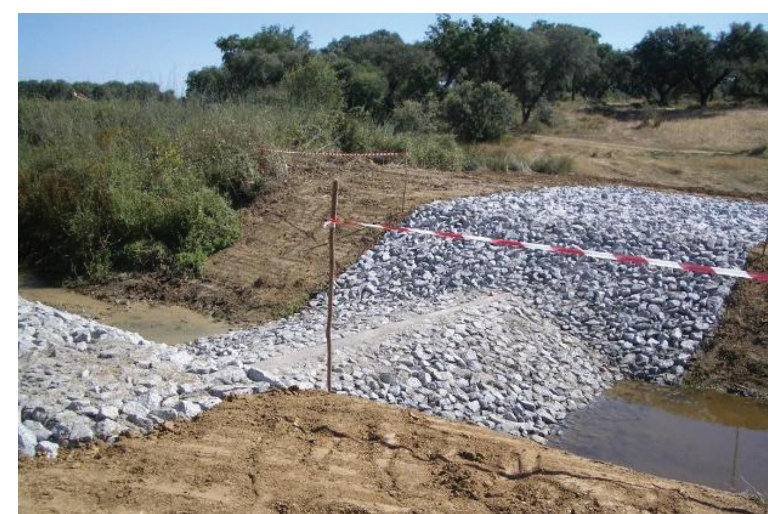
Construção de soleiras: detalhe da soleira e enrocamento
