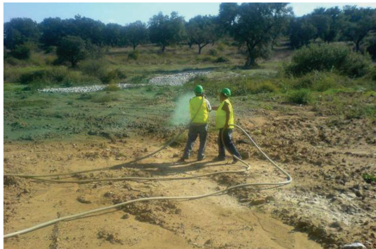
Hidrosementeira para estabilização de taludes e controle de erosão
