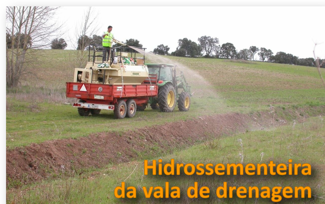
Aspecto geral da vala de drenagem após intervenção
