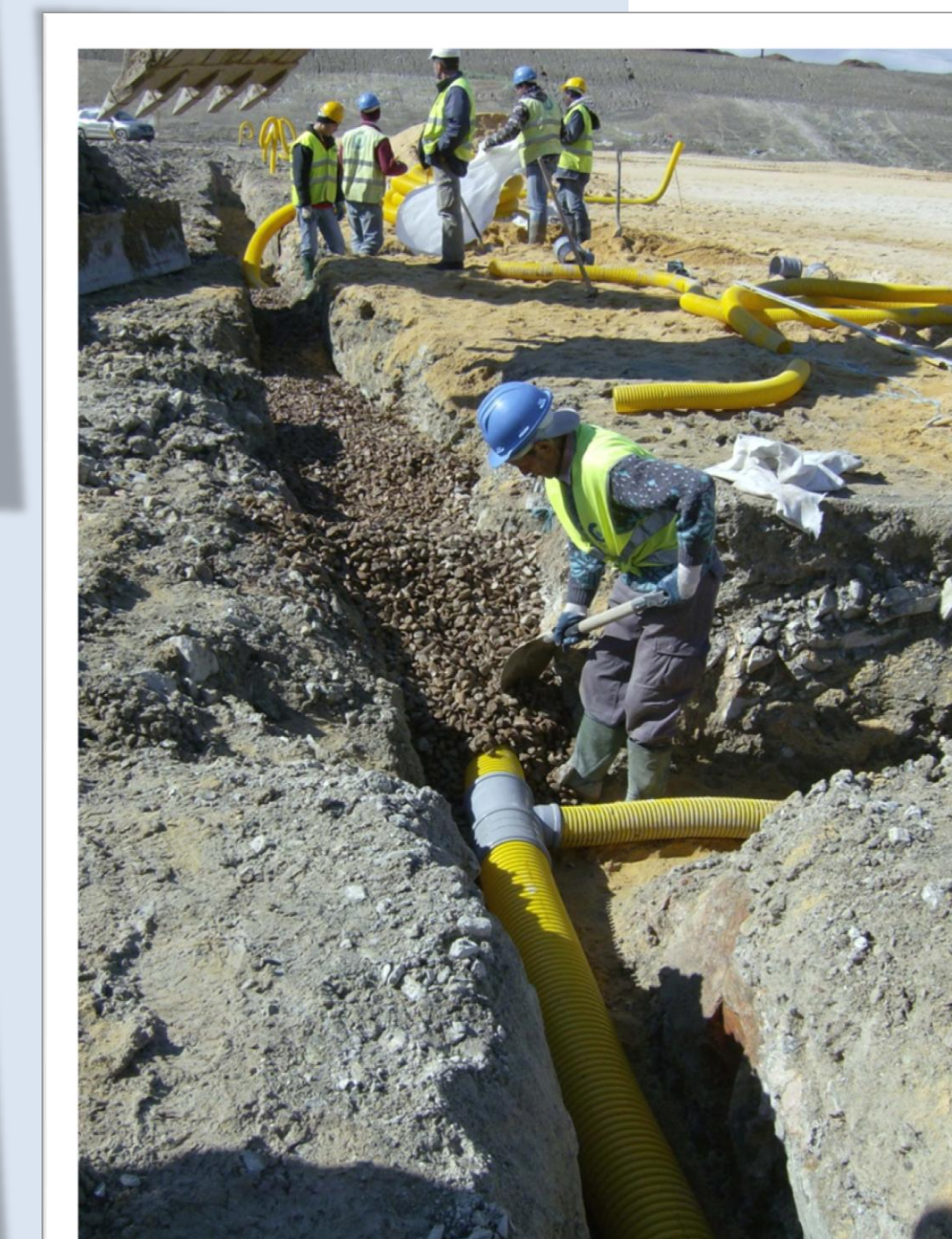
Instalação do sistema de drenagem interno
