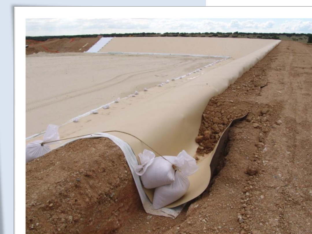
Pormenor construtivo da fixação da geomembrana
