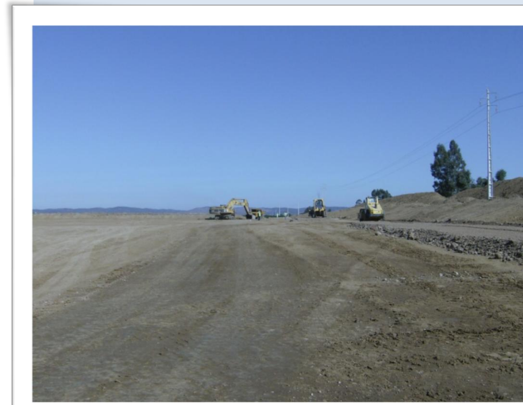
Execução de aterro experimental
