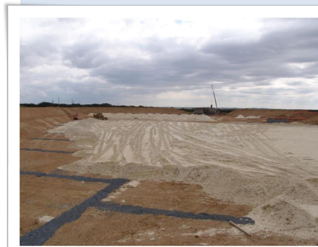
Colocação da camada de base (é possível ver o sistema de drenagem interna)
