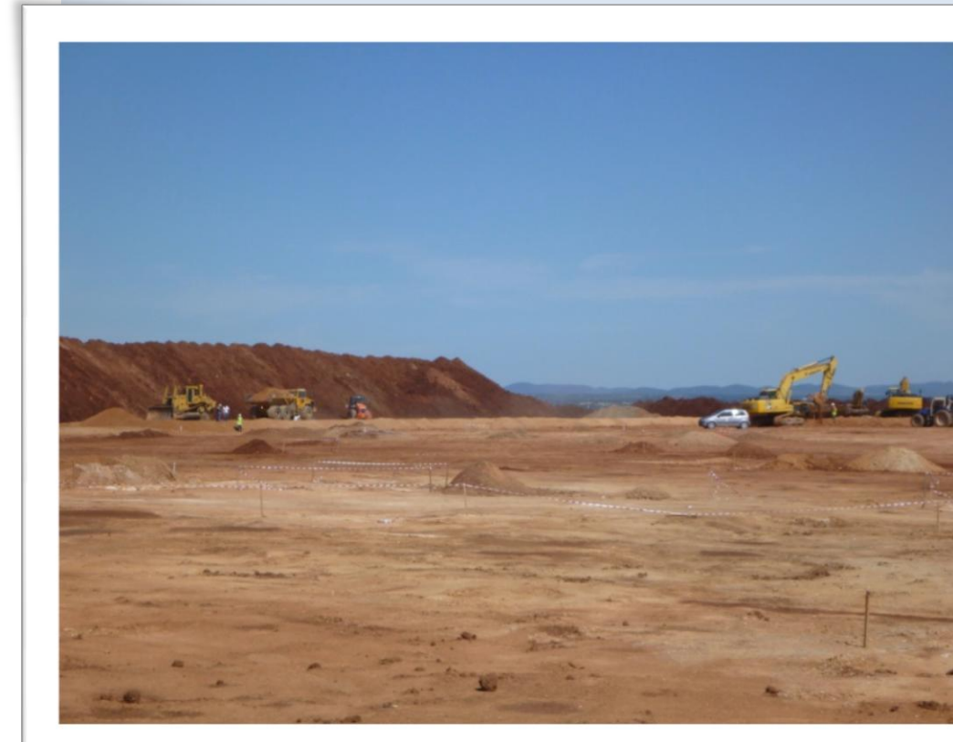
Preparação e regularização da fundação
