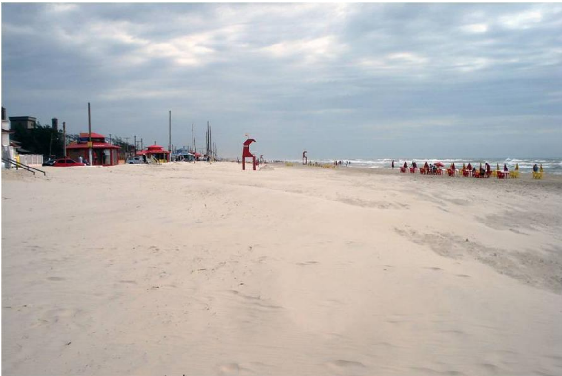
Figura 9. Vista da praia de Imbé no Setor Sul, sede municipal, onde as dunas frontais foram suprimidas pela urbanização pública. Data: 27 de dezembro de 2011.
