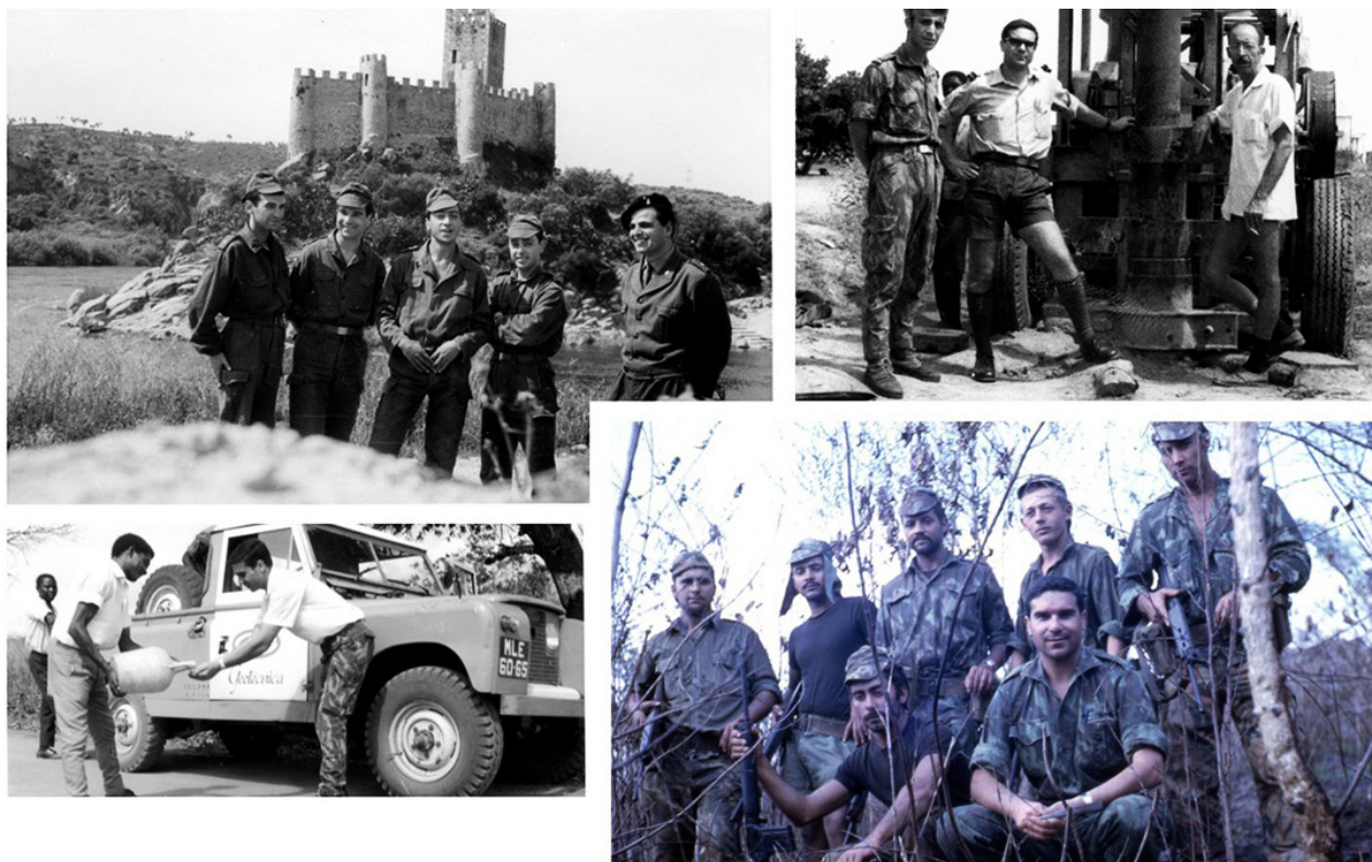
Figura 1. O intenso período de 1967 a 1973: de Tancos a Moçambique (Polígono Militar de Tancos, cinco geólogos/ sapadores pontoneiros de engenharia na Engenharia Militar, Rio Tejo, Almourol, em Maio de 1967; Mucojo, Sonda de percussão Mangold da Geotécnica & Minas; com o Mestre-Sondador António Pereira, Março de 1969; Nova Mueda – Montepuez, Geotécnica & Minas, Agosto de 1968; ‘Pelotão das Águas Subterrâneas’, ladeado pelos seus camaradas e Martins Carvalho empunhando o clássico martelo de geólogo Estwing na região montanhosa de Mapé, no Planalto dos Macondes, ca. 1968). (Fotos: arquivo da família Carvalho)
