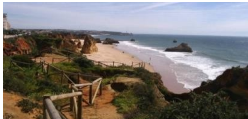
Vedação de zonas de risco
